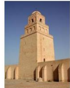
Minaret of the Mosque of Uqba (Kairouan - Tunisia)
