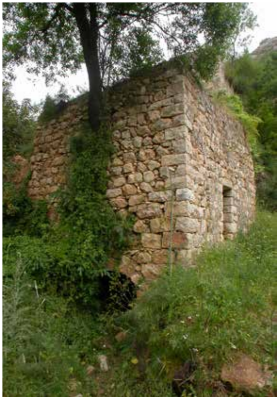
מימין: עץ שקד שצמח בקיר טחנת הקמח | משמאל: הטחנה לאחר ההתמוטטות
