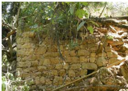
מימין: השפעות הצמחייה על הידרדרות שרידי המבנים | במרכז: הובלת ציוד בידים משמאל: ייצוב קירות בעזרת אבנים ויתדות אבן
