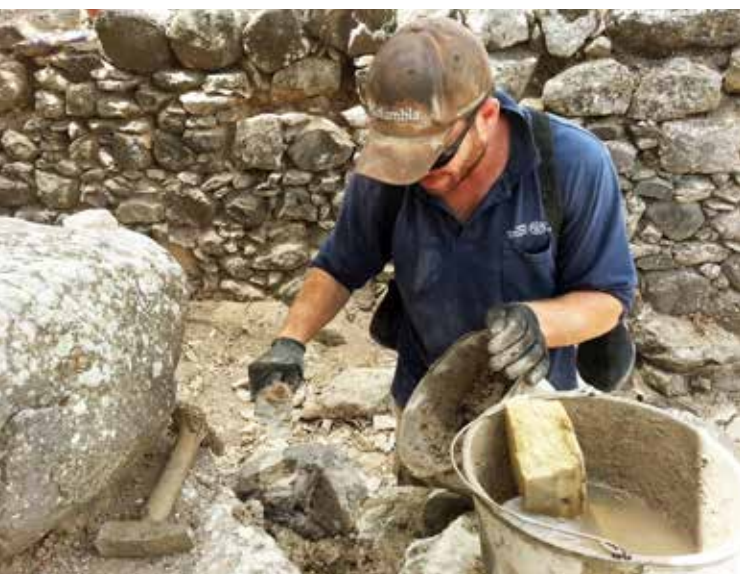
משמאל, בית הכנסת בגוש חלב. עמית רזנבלום, ראש צוות השימור, משלים אבנים חסרות במהלך עבודות לייצוב ראש הקיר
