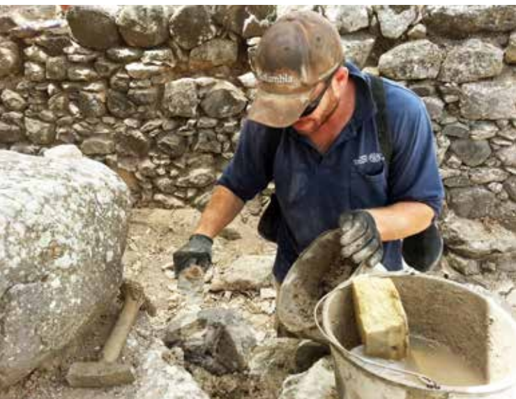
משמאל, בית הכנסת בגוש חלב. עמית רוזנבלום, ראש צוות השימור, משלים אבנים חסרות במהלך עבודות לייצוב ראש הקיר
