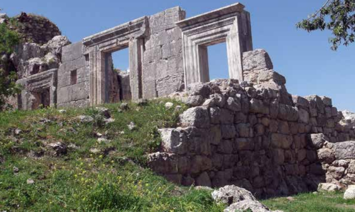
בית הכנסת במירון. מבט מדרום מזרח על קיר התמך והחזית בסיום עבודות השימור
