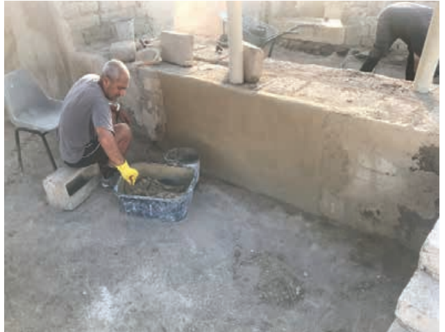
איור 8 | טיח בוץ יישום שכבת גמר צילום: אילן פחימה, 2018
