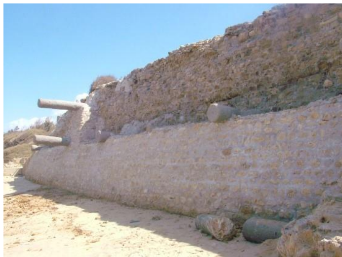
איור 40. קיר העמודים בגן לאומי תל אשקלון. מימין, הקיר לפני טיפול; משמאל, שכבת הקרבה בבניית דבש להגנה מפגיעת גלי הים. הדבש מחקה את שכבות הליבה החשופה
