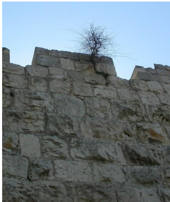
איור 4. מימין, נזקי שיח הצלף בשינויות חומות ירושלים; במרכז, שורשים מפרקים חיפוי שיש בברכה קדומה בחמת גדר; משמאל, עץ מפרק קירות בחפיר החומה הצלבנית בגן לאומי קיסריה.
