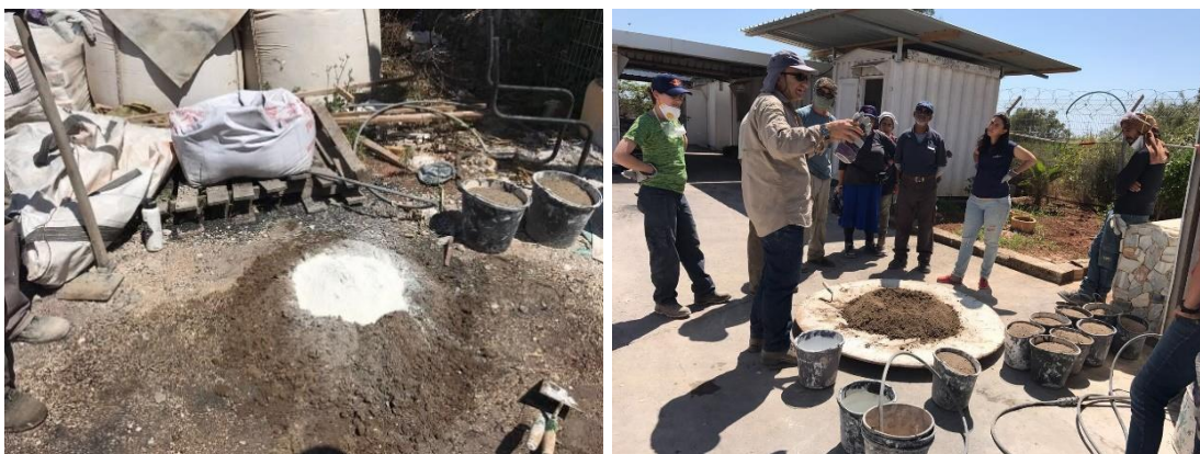
איור 7. תערובת הוטמיקס: הכנות לערבוב סיד חי ואדמה מקומית, ללא מים.
