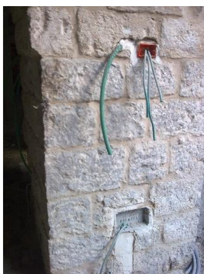
איור 45. מימין, פריטים קדומים משולבים בקיר מודרני, צפת העתיקה; במרכז, התקנת חשמל בקיר קדום אגב חציבת האבן המקורית, חאן שווארדה בעכו העתיקה; משמאל, שקע חשמל מוצמד לאבן מקורית, מוזיאון קצרין
