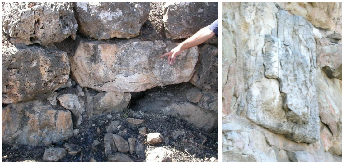
איור 32. התקלפות אבן כתוצאה משריפה. מימין, התקלפות אבן וסימני שריפה בעת העתיקה בחומת ירושלים, כיכר צה"ל; משמאל, שריפה כתוצאה מנזקי מלחמה בחורבת הונין
