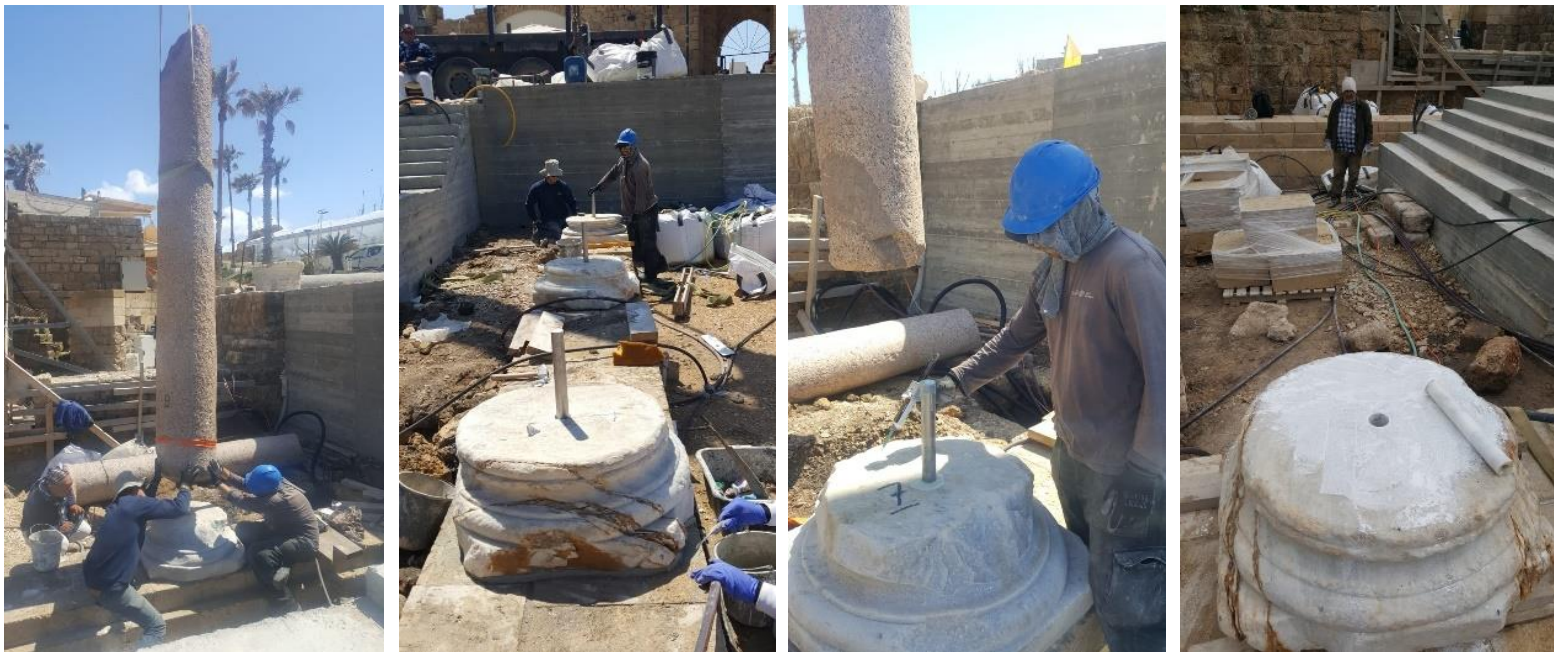
איור 25. מימין לשמאל, קידוח יחיד במרכז הבסיס, החדרת מוט טיטניום והצבת עמוד בפורטיקו שליד קמרונות הנמל בקיסריה. שים לב לאופן החביקה ברצועות ההרמה. צילום: ג'ון פיטרסון
