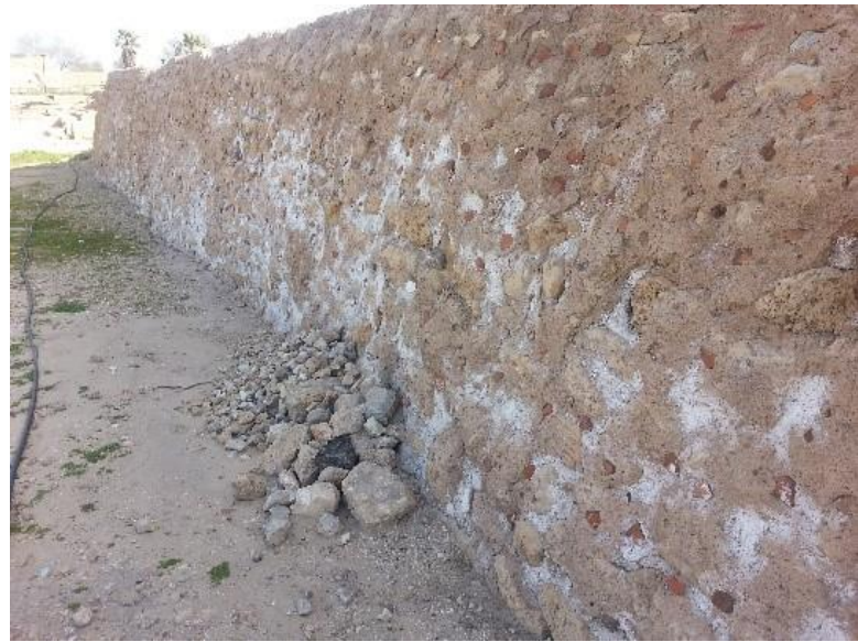
איור 14. גן לאומי קיסריה: קיר תמך עשוי 'דבש' מחופה טיט. ניתן להתרשם מכמויות המלחים המגיעות אל פני השטח
