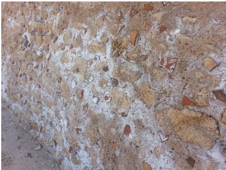
איור 14. גן לאומי קיסריה: קיר תמך עשוי 'דבש' מחופה טיט. ניתן להתרשם מכמויות המלחים המגיעות אל פני השטח
