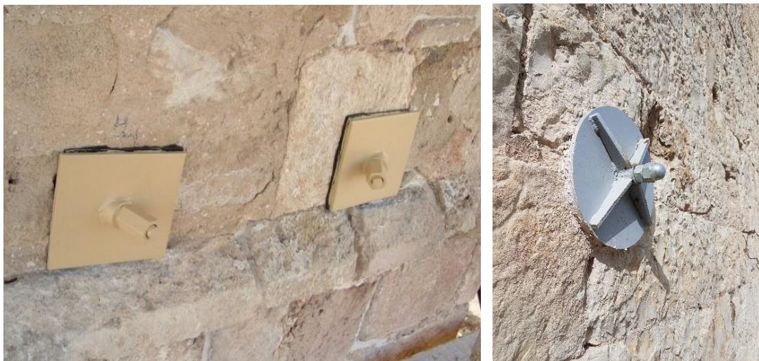
איור 28. עוגנים. מימין, טיט בגב הפלטה, עיגון במגדל צדק; משמאל, ניאופרן בגב הפלטה, מינרט תל יבנה
