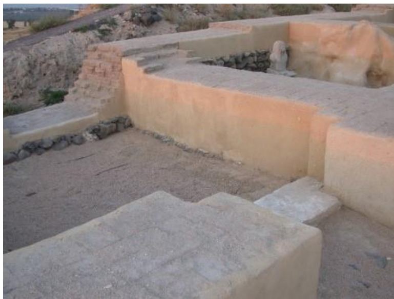
איור 10. בית המושל המצרי בתל בית שאן. מימין, השכבה העליונה היא קופינג מלבנים חדשות. בדופן הקיר שרידי הטיח המתפורר שמחודש בפעולות תחזוקה מדי שנתיים; משמאל: לאחר חידוש הטיח. יסוד הקיר עשוי אבני בזלת. צילום: אילן פחימה, 2018
