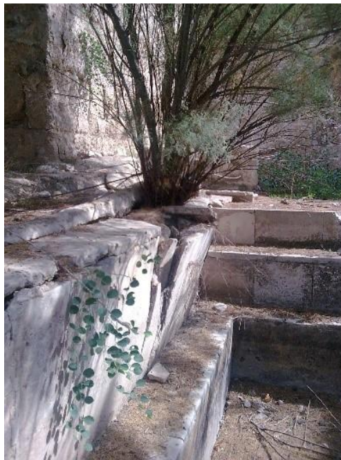
איור 4. מימין, נזקי שיח הצלף בשינויות חומות ירושלים; במרכז, שורשים מפרקים חיפוי שיש בברכה קדומה בחמת גדר; משמאל, עץ מפרק קירות בחפיר החומה הצלבנית בגן לאומי קיסריה.
