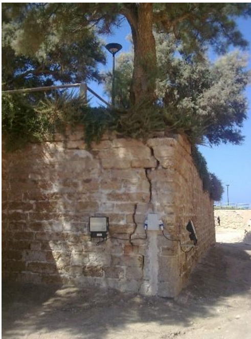
איור 4. מימין, נזקי שיח הצלף בשינויות חומות ירושלים; במרכז, שורשים מפרקים חיפוי שיש בברכה קדומה בחמת גדר; משמאל, עץ מפרק קירות בחפיר החומה הצלבנית בגן לאומי קיסריה.
