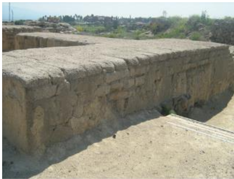
איור 10. בית המושל המצרי בתל בית שאן. מימין, השכבה העליונה היא קופינג מלבנים חדשות. בדופן הקיר שרידי הטיח המתפורר שמחודש בפעולות תחזוקה מדי שנתיים; משמאל: לאחר חידוש הטיח. יסוד הקיר עשוי אבני בזלת. צילום: אילן פחימה, 2018
