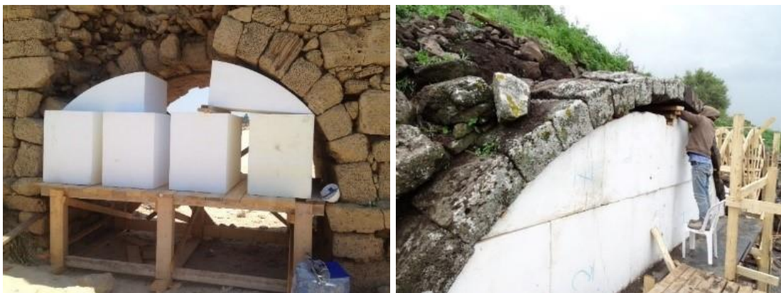
איור 30. תבנית גושי קלקר לתמיכת הקשת לצורך טיפול. מימין, עין קשתות (אום-אל-קנאטיר) רמת הגולן; משמאל, אמת המים בקיסריה.
