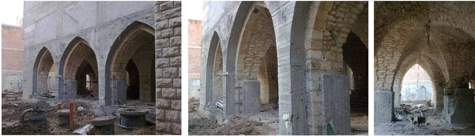
איור 46. נצרת – מבנה קמרונות מהתקופה העות'מאנית "עטוף" במבנה בטון לצורך בניית קומה עליונה.
