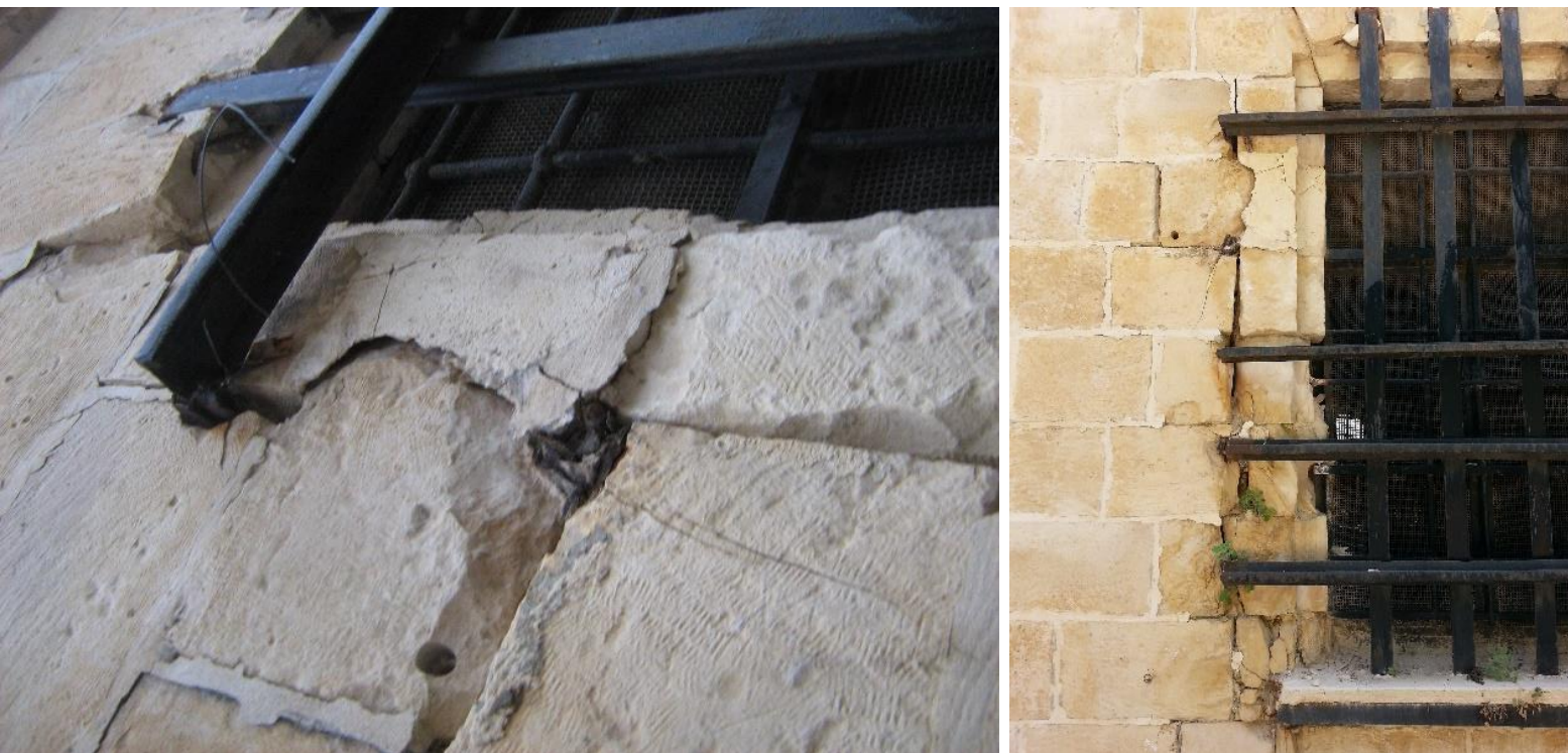
איור 6. החלדת מתכת הסורג מרסקת את אבני הקיר, מוזיאון אסירי המחתרות בירושלים
