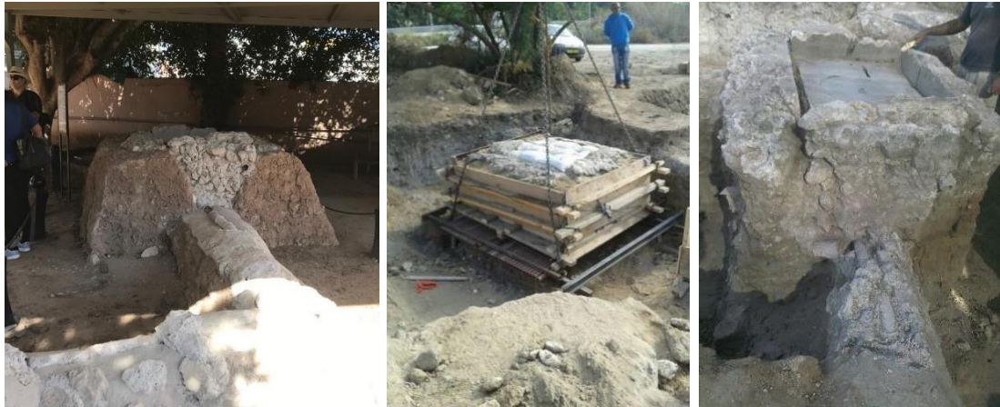
איור 29. העתקת מתקן מזרקה ברמלה. מימין, המזרקה במיקומה המקורי; במרכז, המתקן מוכן להנפה; משמאל, הצבה ושימור לתצוגה במיקום החדש - באתר בריכת הקשתות
