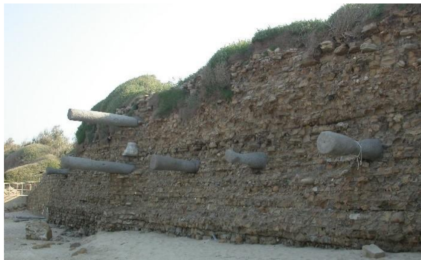
איור 40. קיר העמודים בגן לאומי תל אשקלון. מימין, הקיר לפני טיפול; משמאל, שכבת הקרבה בבניית דבש להגנה מפגיעת גלי הים. הדבש מחקה את שכבות הליבה החשופה
