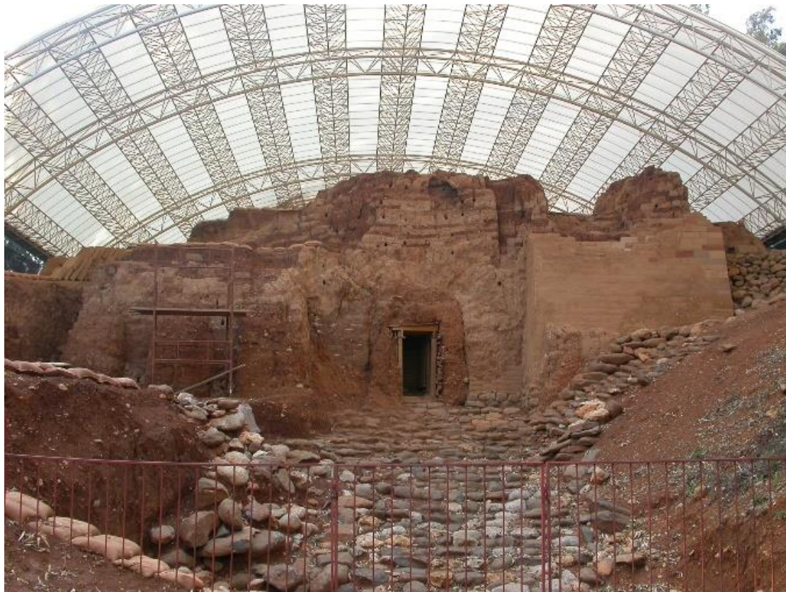
איור 9. שער הלבנים בתל דן. מבנה השער בן 4000 שנה לערך. מימין קיר לבנים חדשות שנבנה לתמיכה. מעל למבנה קירי מודרני להגנה מפני גשם ישיר וקרינת השמש.
