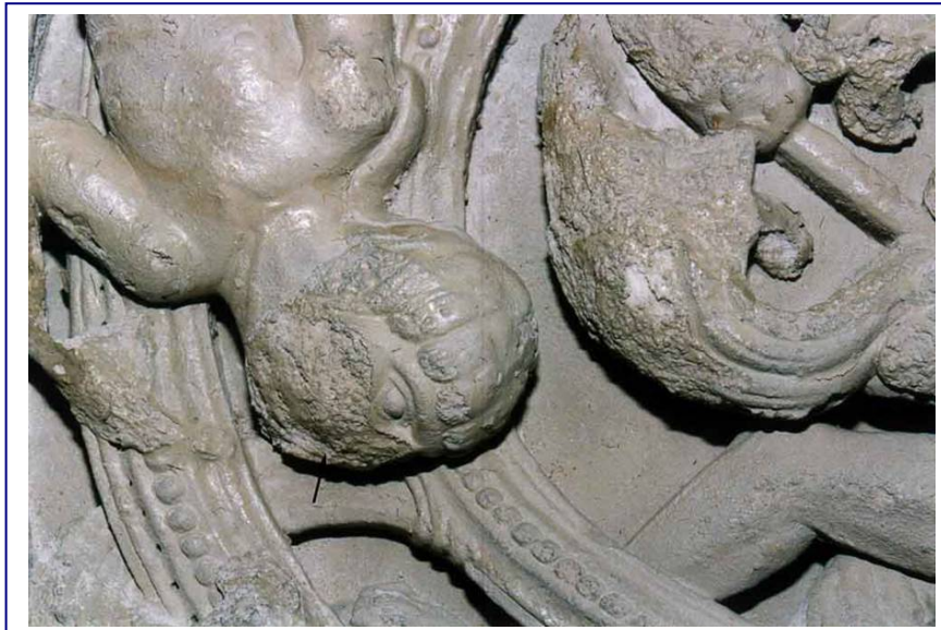
דוגמא להתפוררות של אבן שיש בארכיטרב מעוטר מכנסיית הקבר, ירושלים
